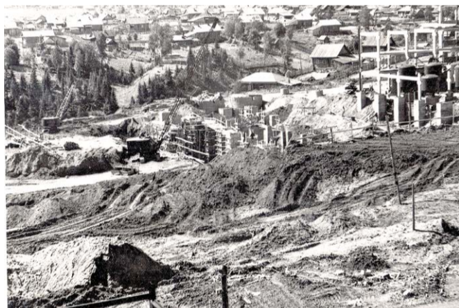
Начало строительства котельной, 1965 г.
