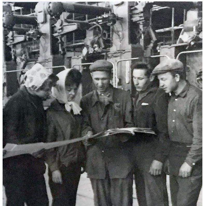
Заканчивается монтаж КП-06. Планерка перед сменой
