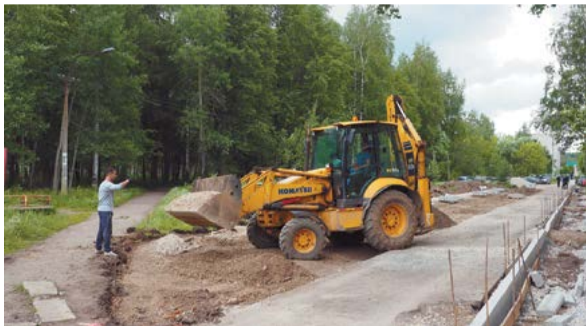
Ремонтные работы на улице Сухумской, 19
